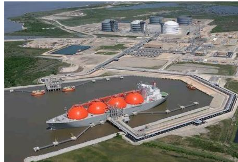
Sabine Pass LNG export terminal
